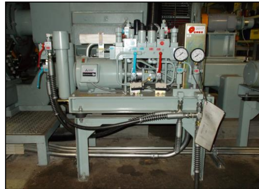
制動装置油圧ユニットの整備
