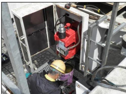
非常制動機更新
