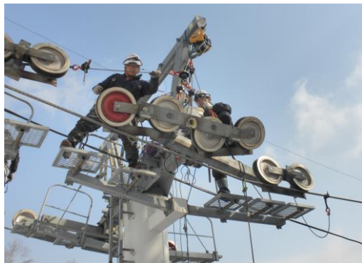
圧索装置の分解整備
