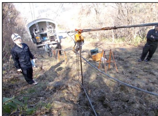
えい索の切り詰め工事
