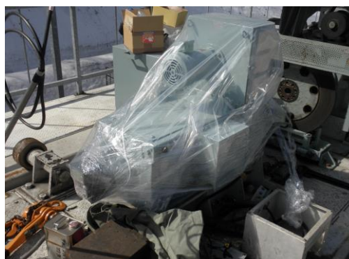
電動機オーバーホール
