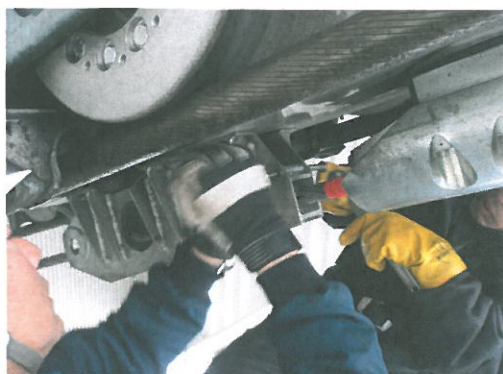
接続装置解体点検、搬器移
