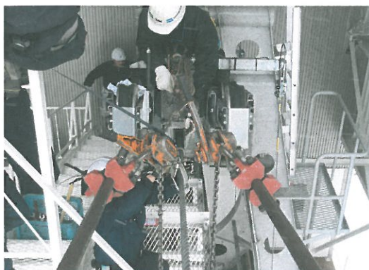
接続装置解体点検、搬器移
