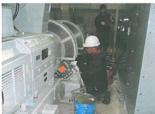
減速機のオイル交換
