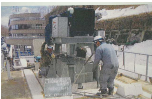
予備原動機オーバーホール
