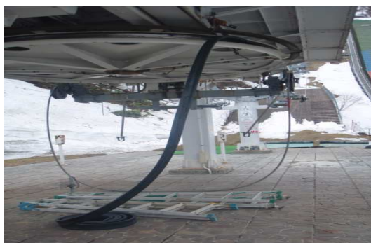
原動緊張滑車ゴムライナー交換
