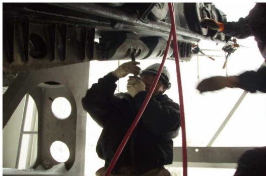
接続装置解体点検、搬器移動
