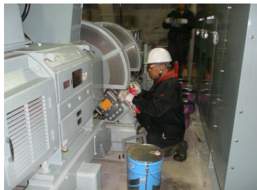
制動装置関係の点検
