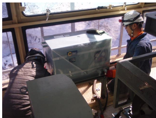
制動装置油圧ユニット更新
